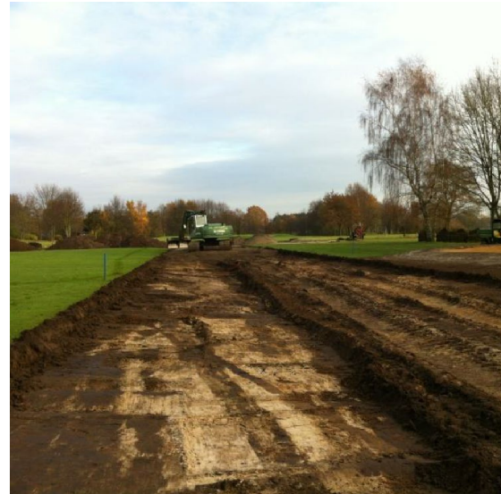
Absoden des Fairways A9 und Abtragen der Rasentragschicht im Muldenbereich
