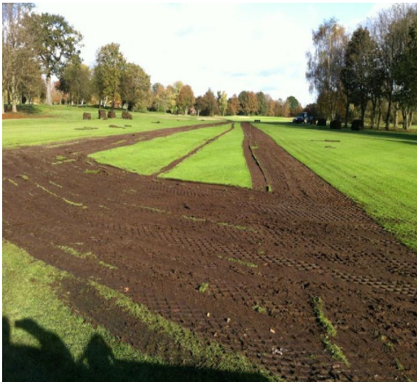
Absoden des Fairways A9 und Abtragen der Rasentragschicht im Muldenbereich
